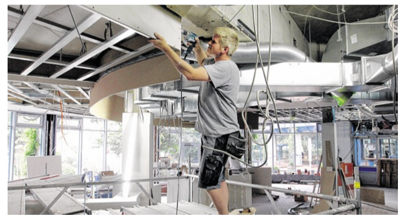
Die Bauarbeiten schreiten zügig voran.
